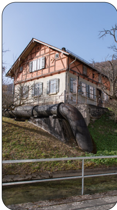
Ehemaliges Maschinenmeisterwohnhaus, im Vordergrund: die Triebwasserleitung
