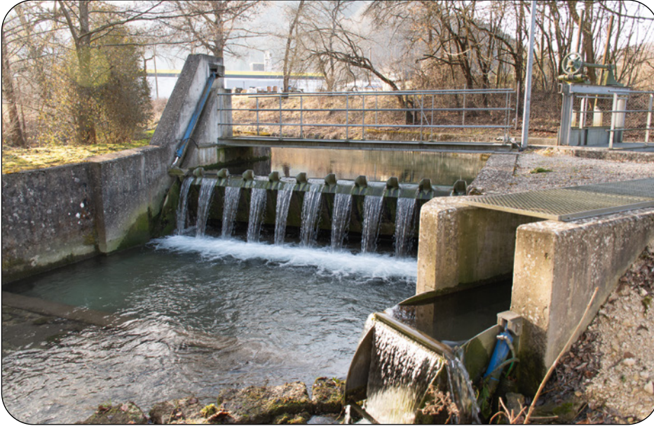
◀ Wehranlage der Fils bei Wiesensteig
