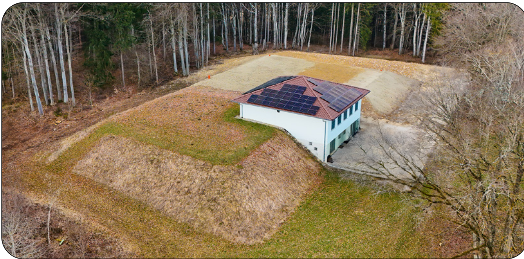
◀ Hochbehälter »Horn« , wurde im Jubiläumsjahr um eine PV-Anlage und eine dritte Wasserkammer erweitert.
